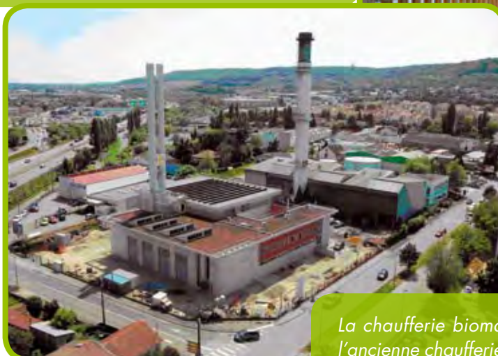
350 m 2 de panneaux voltaïques ont été installés sur la chaufferie biomasse de Vandoeuvre
